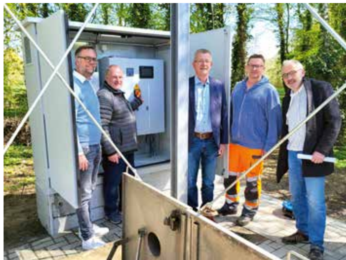
Nahmen die neue Druckrohrleitung von Vehrte nach Schwagstorf an der Pumpstation Vehrte offiziell in Betrieb: Marcus Hensing (Gemeinde Belm, v.li.), Rainer Ellermann (Verbandsvorsteher Wasserverband Wittlage), Uwe Bühning (Geschäftsführer Wasserverband Wittlage), Gunnar Marenke (Ltr. Kläranlage Belm), Jörg Klimasch (Projektleiter).
