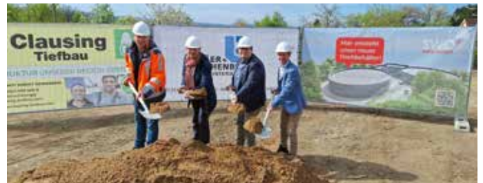
Den symbolischen ersten Spatenstich für den neuen Hochbehälter am Schinkelberg setzten jetzt (v. l.) Christoph Miemietz (Projektleiter), Daniel Waschow (SWO-Vorstandsvorsitzender), Tino Schmelzle (Geschäftsführer SWO Netz) und Nico Kuschel (Leiter Wasserwerke und Kläranlagen SWO Netz).
