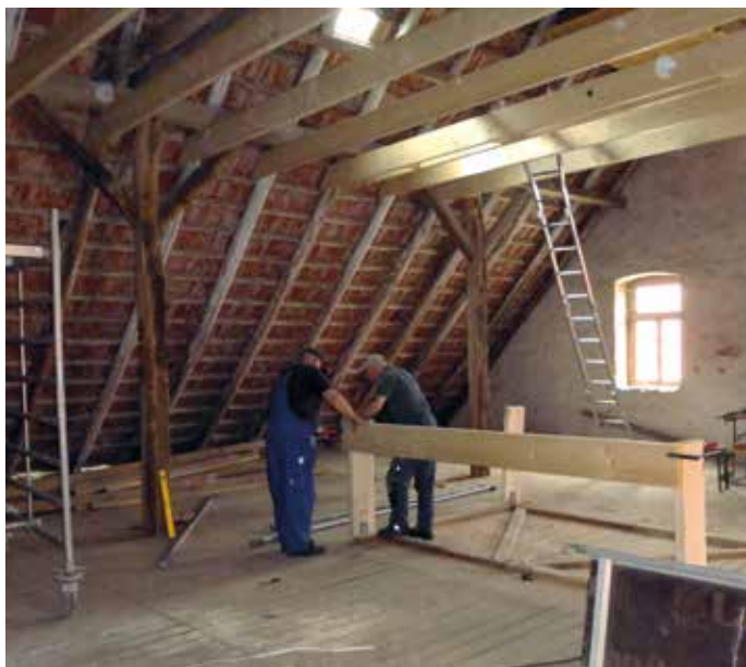
Dachboden Hof Eickhoff
