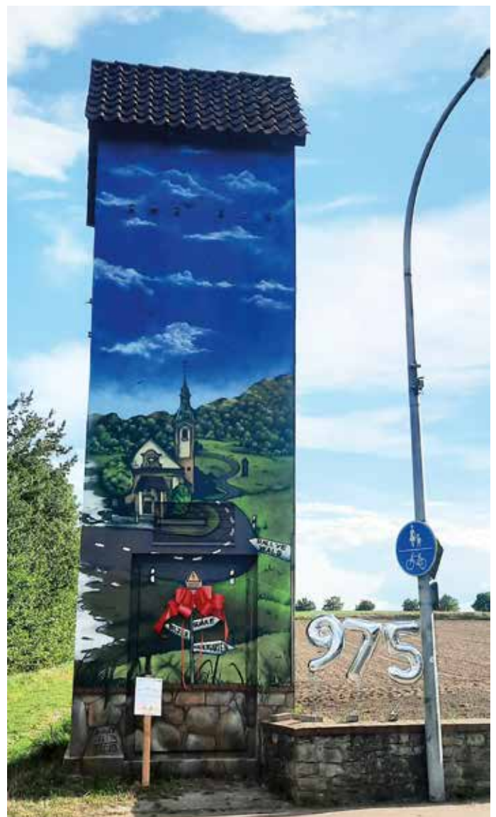
Blick auf den neu gestalteten Trafoturm
