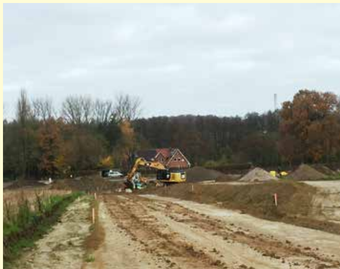
Auch die Erschließung kommt voran ... hier entsteht der Frieda-Nadig-Weg.
