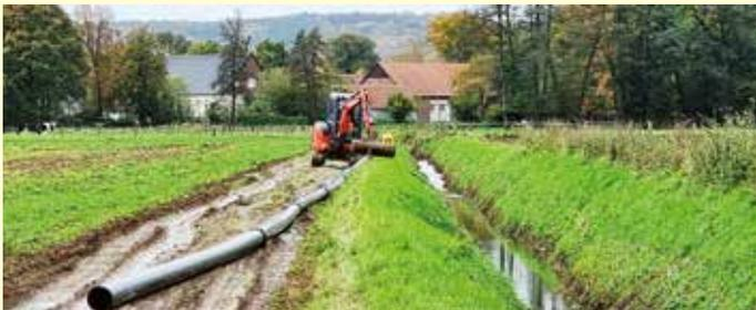
Im Bau ist derzeit die Abwasser-Druckrohrleitung zwischen Vehrte und der Kläranlage in Schwagstorf. Die Leitung soll die Kläranlage in Belm entlasten. Foto: Wasserverband Wittlage
