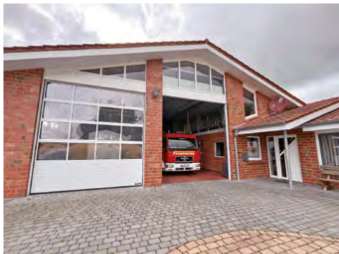
Der (noch) leere Vorplatz des Feuerwehrhauses
