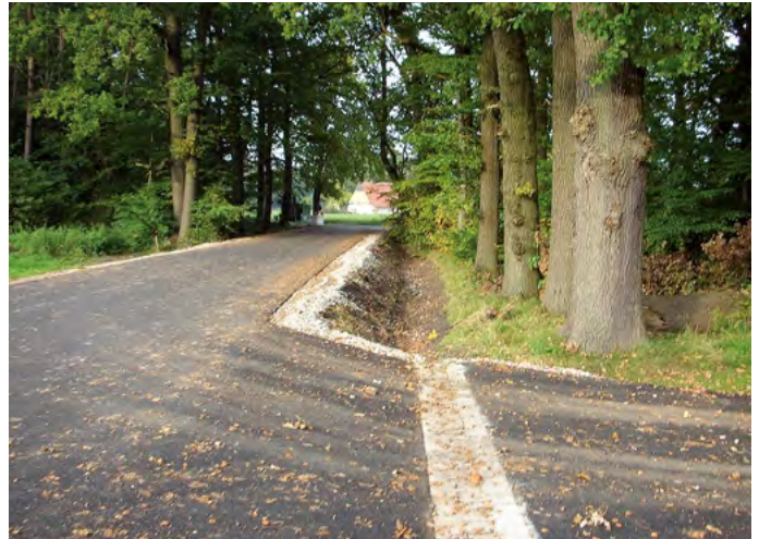
Straßenerhöhung am Linner Weg zwischen Bruchwaldflächen, Foto: HI Nord Planungsgesellschaft mbH
