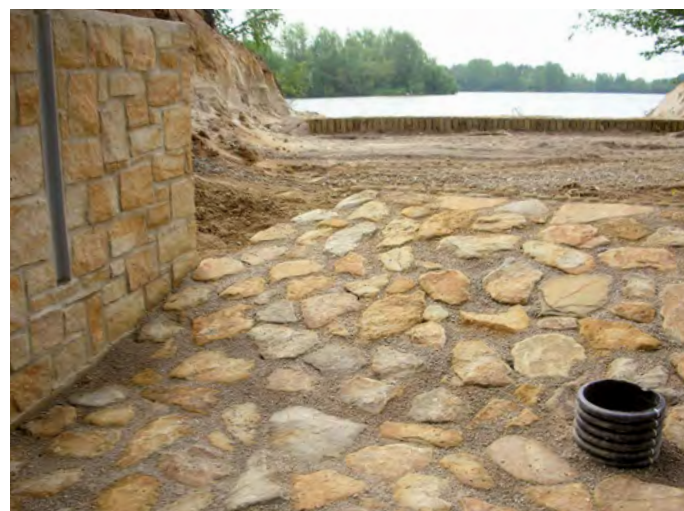
Die Flutmulde zwischen Wierau und Linner See bei der Entstehung. Foto: HI Nord Planungsgesellschaft mbH
