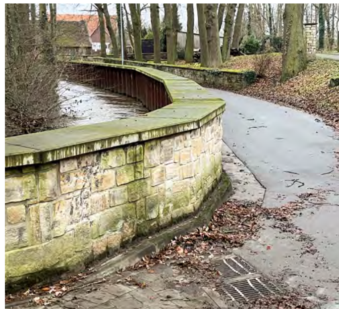
Die Spundwand in Bruchsteinoptik schützt die Straße „An der Wierau“ an der Engstelle des Flusses. Foto: Gemeinde Bissendorf/Kollorz
